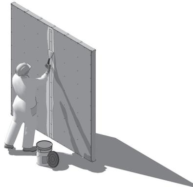
Retirar el exceso de masilla, dejando una cantidad suficiente para permitir la adhesión a la placa. Se debe tener precaución de no dejar tramos o bordes sin pegar ni ondulaciones.
